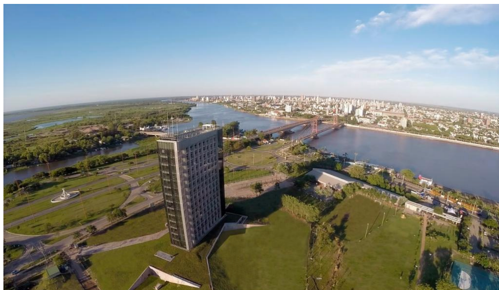
Imagen 12: Vista aérea del Hotel UNL-ATE. Fuente: http://www.hotelunlate.com.ar/#hotel
