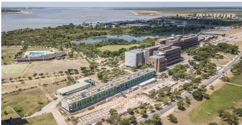
Imagen 13: Vista aérea de residencias universitarias y área académica. https://www.ate.org/institucional/tipo/not/id/4081/residencias-estudiantiles-unl-ate-18-nuevos-departamentos-y-comienzo-de-construccion-de-un-segundo-edificio.html
